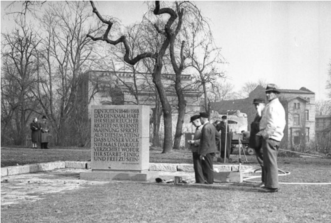
Bauarbeiter stellen den Gedenkstein auf dem Friedhof der Märzgefallenen 1948 auf
